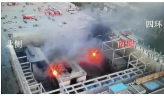
图 7：4·16 北京储能电站火灾事故现场
