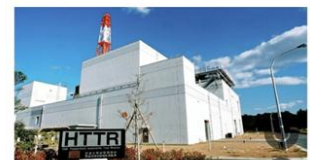
茨城县大洗町的高温工学试验研究炉
