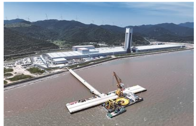
图表25 东方电缆宁波北仑海缆生产基地
